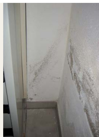
Bild Links zeigt eine typische Schotterbetonmauer (60er-Jahre). Hier ist es schwierig eine Abdichtung auszuführen.
