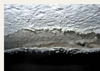
Bild Links zeigt eine typische Schotterbetonmauer (60er-Jahre). Hier ist es schwierig eine Abdichtung auszuführen.
