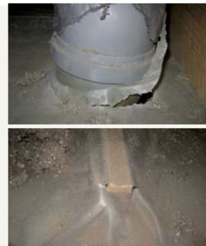
Durchstoßene Dampfsperre im Zwischendeckenbereich bei bereits eingetretenem Schaden.
